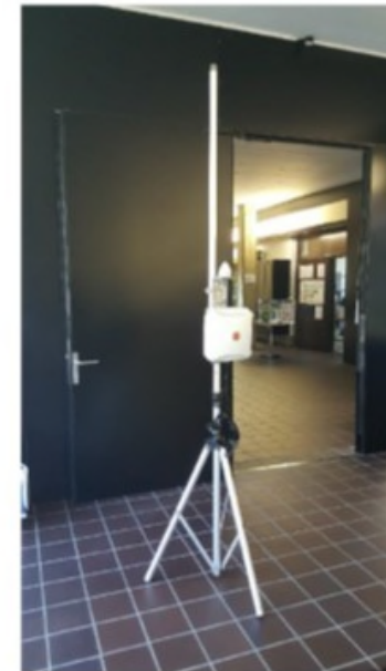
Abb. 2: Foto Antennen auf Stativ, LoRa- Antenne, GPS- Antenne, LTE- Antenne
